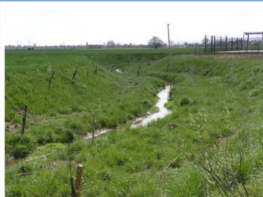
Bild 144: Bauliche Anlage einer Sekundäraue innerhalb intensiv genutzter landwirtschaftlicher Flächen durch Profilaufweitung auf Mittelwasserniveau (Foto: U. KOENZEN)
