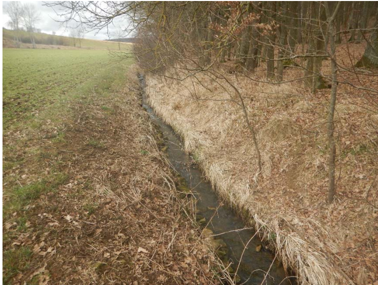
Abbildung 32: Uhlgraben (Abschnitt 2-1): Anlage Gewässerrandstreifen (extensiv) am südlichen Ufer, Uferverbau entfernen (am südlichen Ufer), Acker in Grünland umwandeln
